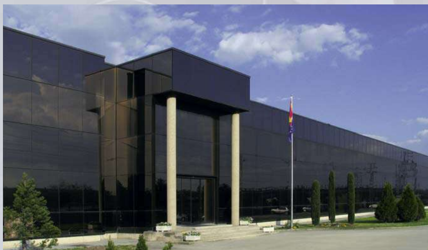
Instalaciones del Grupo Nicolás Correa en Burgos
