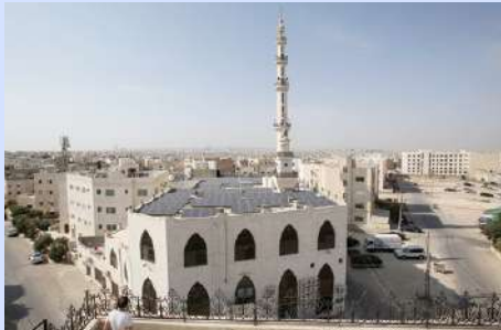
Un conjunto de 140 paneles colocado en la parte superior de la mezquita Hamdan al-Qara, generando casi 44 kilovatios de energía. Fuente: Páginas web Kuwait Times y The Daily Star.
