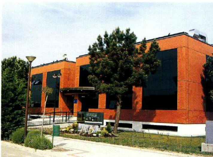
Nuevo edificio de CARTIF.
