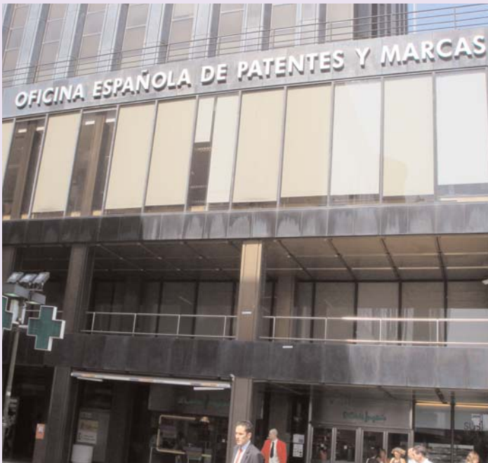
Nueva sede de la Oficina Española de Patentes y Marcas en el paseo de la Castellana de Madrid
