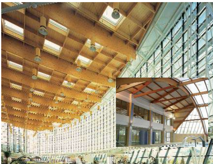
Estructura mixta espacial y madera (Centro Comercial Sanchinarro, Madrid)
