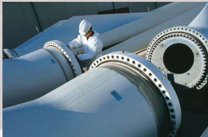
Montaje de palas eólicas en Albacete
