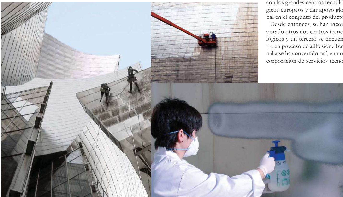
Producto y método para la limpieza de superficies de titanio aplicado en el Museo Guggenheim de Bilbao
