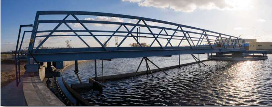
Instalaciones realizadas por Dytras en Choutrana (Túnez)
