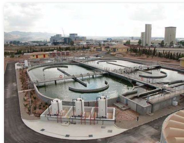
Instalaciones realizadas por Dytras, S.A. en Alhama de Murcia
