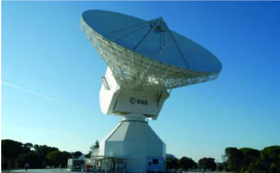
Fig. 75 Antena de 35 metros en la estación de espacio profundo de Cebreros 77
