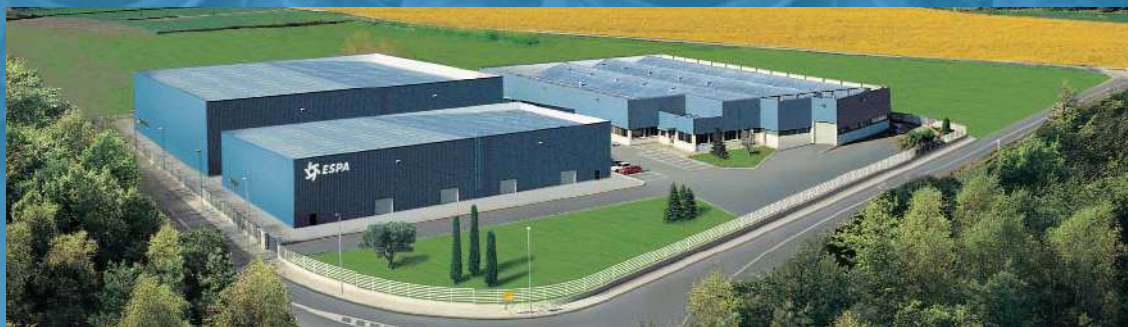
Instalaciones de ESPA en Banyoles (Girona)
