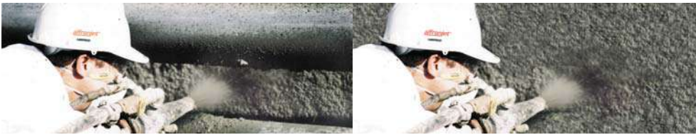
Aplicación de monolíticos mediante la nueva tecnología ALFRANJET
