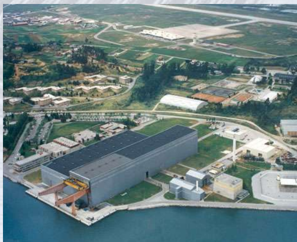
Vista aérea de la fábrica en Maliaño (Cantabria)
