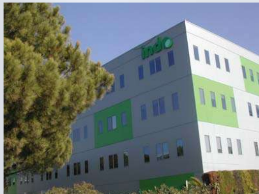
Sede corporativa de INDO en San Cugat, Barcelona
