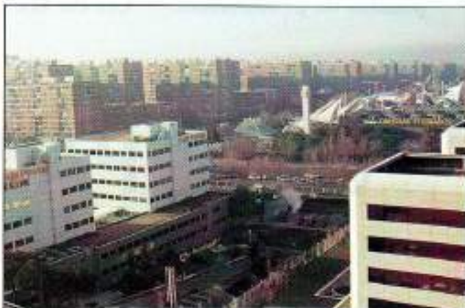
Un proyecto mejorará el encofrado en edificaciones.
