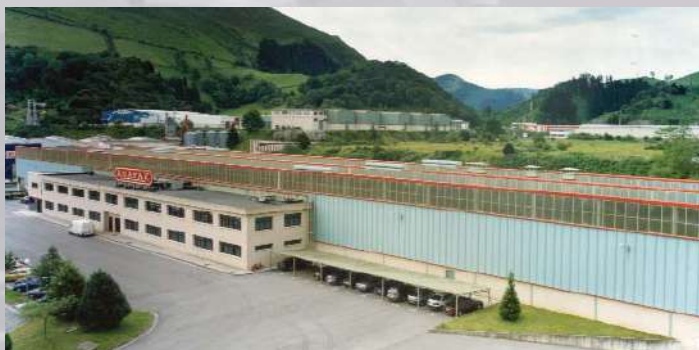
Instalaciones de la empresa en el Polígono Industrial de Itziar (Guipúzcoa)
