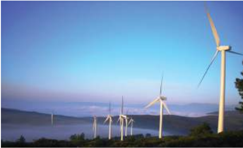
Parque eólico. Cimentaciones reparadas por HCC
