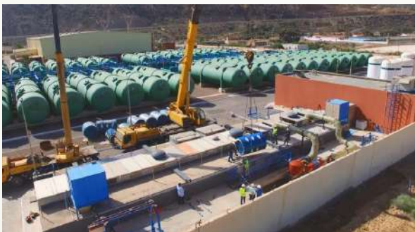
Aqualia ha desarrollado la limpieza de los inmisarios de la desaladora de Mostaganem (Argelia) utilizando la tecnología PIG (Pipeline Inspection Gauge)
