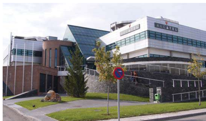
Sede central de Alcatel Espacio en Tres Cantos (Madrid)
