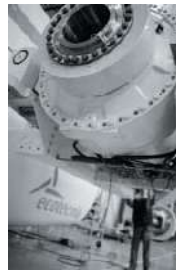
Ensamblaje del aerogenerador 1250
