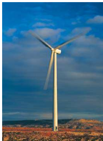
Parque eólico de La Bandera (Navarra)
