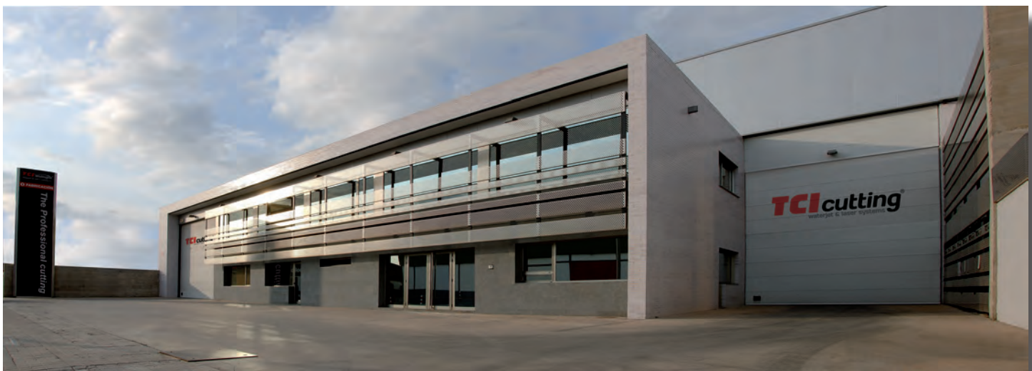
Instalaciones de TCI Cutting.
