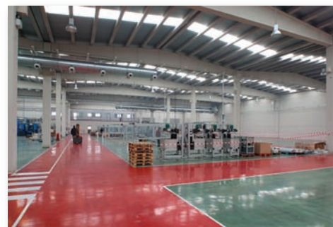
Imagen de una solera industrial ejecutada por Hormilaser S.A.
