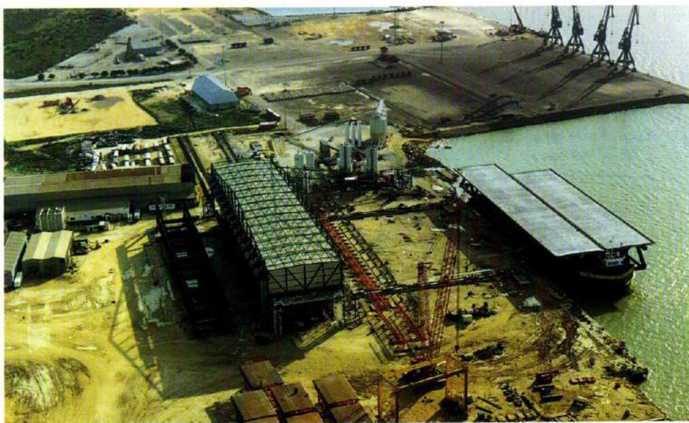
En el centro, uno de los tableros de hormigón que formarán parte del puente.
