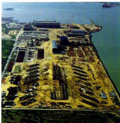
Sobre estas líneas, instalaciones de Dragados Offshore en Puerto Real (Cádiz).
