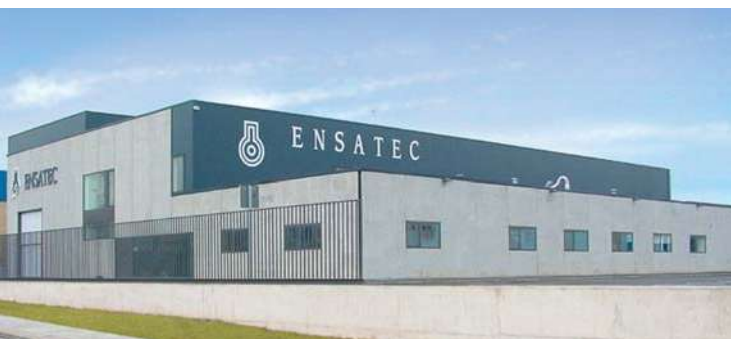
Vista panorámica de las instalaciones
