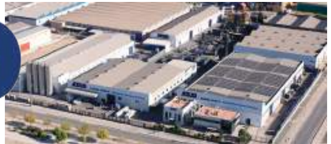
Instalaciones de AZUD en Murcia.
