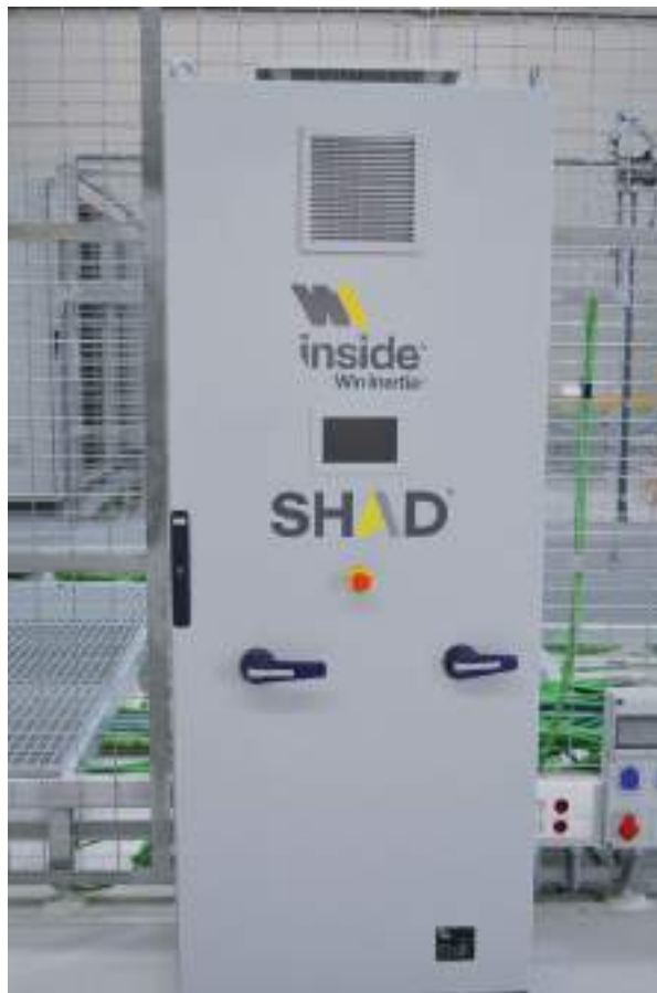
Convertidor de potencia SHAD, especialmente diseñado para la integración de sistema de almacenamiento energético en red.
