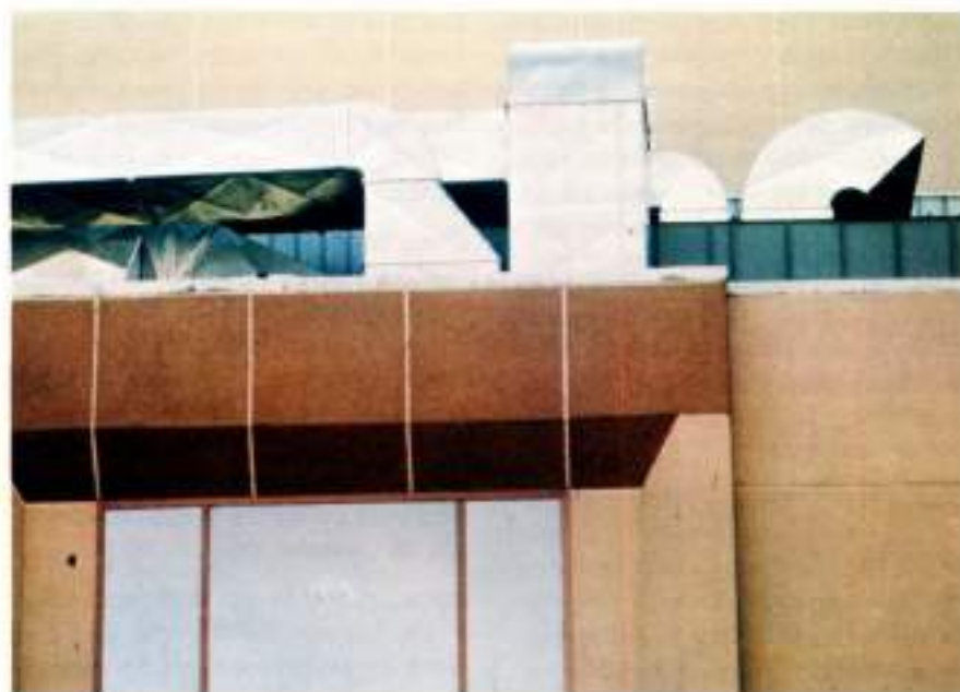
El microprocesador es un sistema efectivo para controlar parámetros de sistemas complejos de aire acondicionado.
