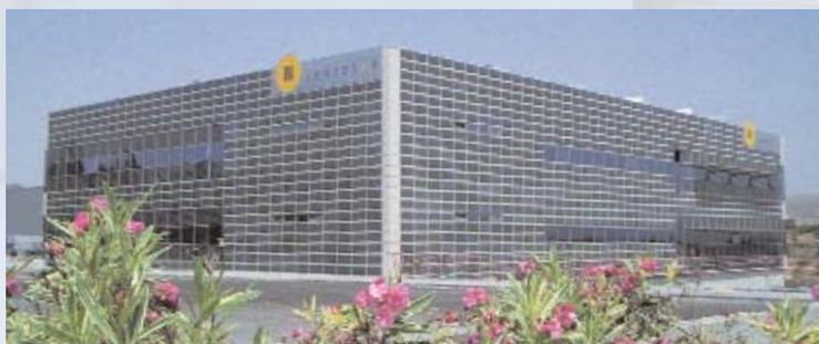
Perspectiva de la fachada de fábrica con módulos fotovoltaicos integrados arquitectónicamente
