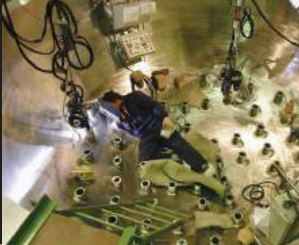
Soldadura automática de CRDMs a tapa de la vasija - Proyecto CDTI
