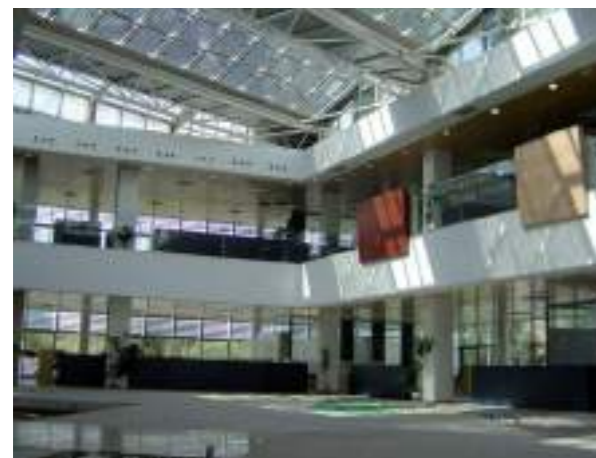
Vista interior del lucernario y la fachada con módulos fotovoltaicos integrados arquitectónicamente
