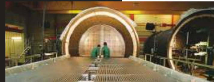
Entubado área limpia
