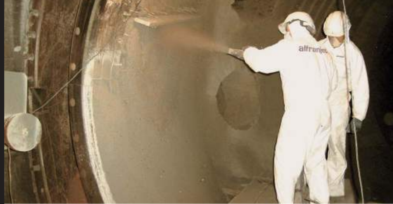
Proyección de Alfranjet en Planta de Cemento
