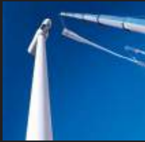
Instalación de pala
