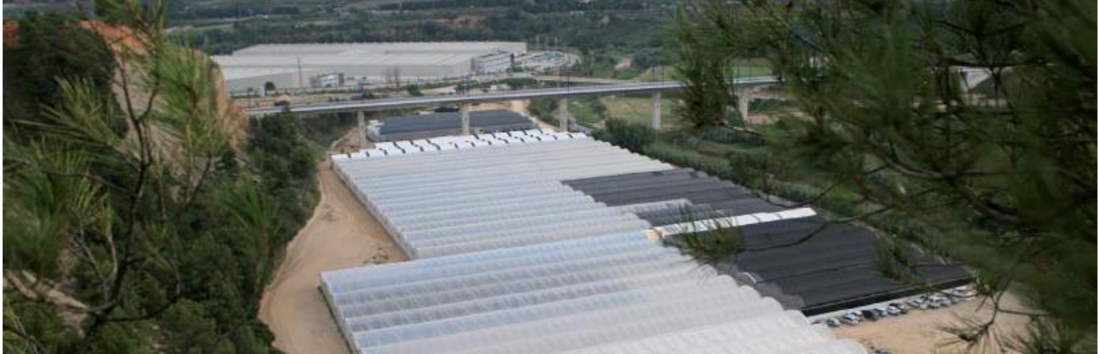
Instalaciones de Agromillora en el Penedès (Barcelona)
