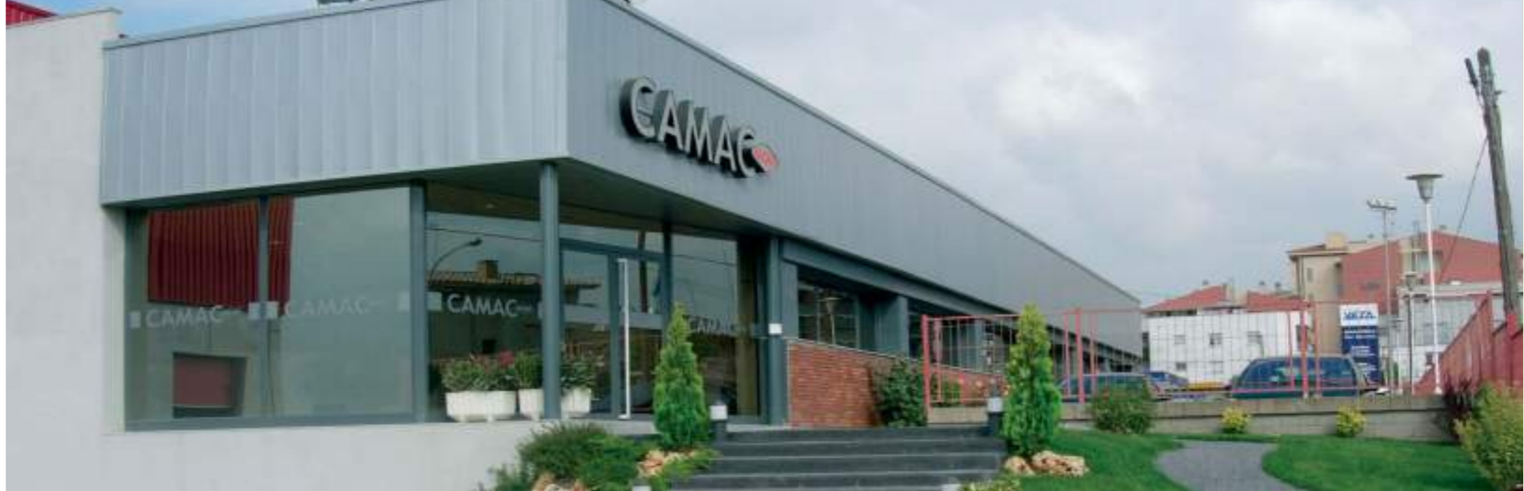
Instalaciones de la planta situada en Esparreguera (Barcelona)
