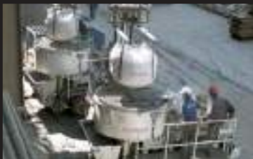
Equipos de Alfranjet en pleno trabajo para bombeo a 100 m de altura
