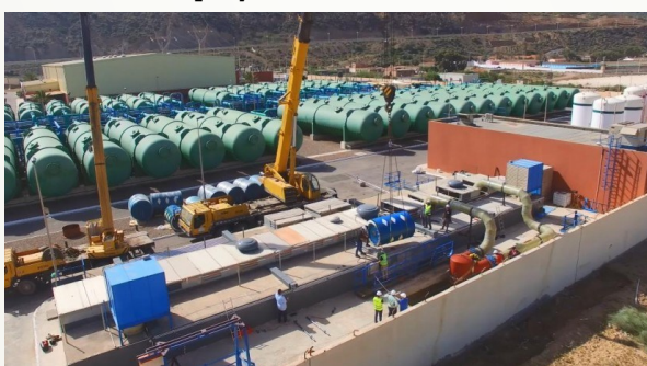
Aqualia ha desarrollado la limpieza de los inmisarios de la desaladora de Mostaganem (Argelia) utilizando la tecnología PIG (Pipeline Inspection Gauge)
