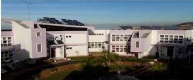
Instalaciones del Centro de equipamientos solares en Bou Ismaïl.
