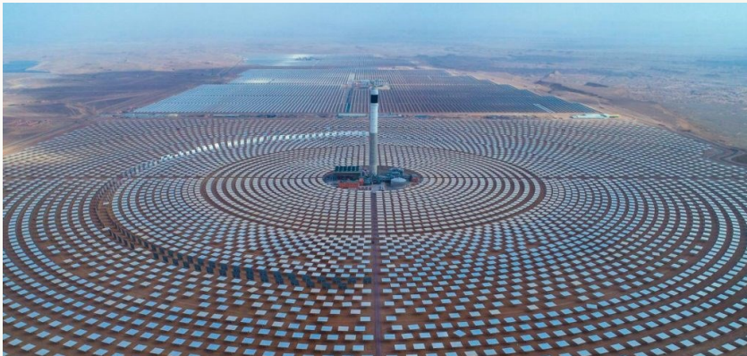
Complejo Solar Noor, Ouarzazate. Fuente: imgur.com
