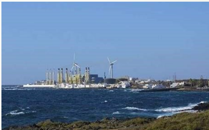
Planta desalinización en Jordania. Fuente: Mena FN
