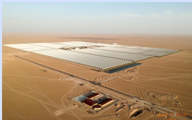
Planta Shagaya de energía solar de concentración de Kuwait. Fuente: cspfocus
