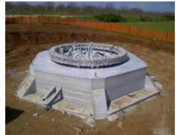
Resultado hormigonado de la losa superior
