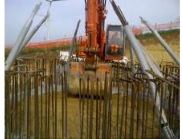
Relleno en el interior del anillo y compactación con la cuchara
