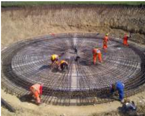
Ejecución de armadura
