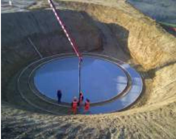
Colocación de encofrado, malla y ejecución del hormigón de limpieza
