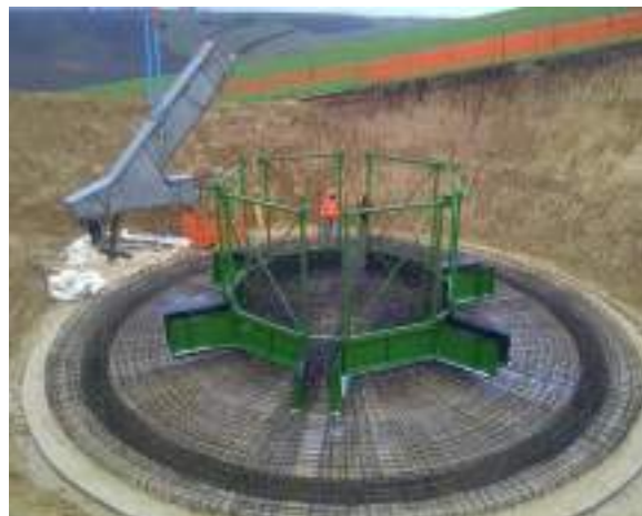
Colocación del encofrado-plantilla y montaje de los jabalcones
