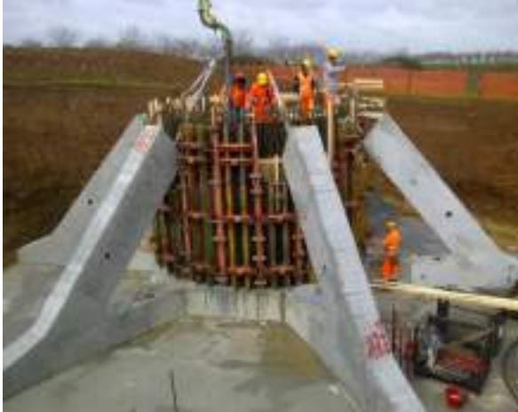
Ferrallado, encofrado y ejecución del hormigonado del anillo
