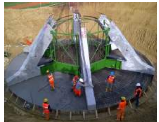
Ejecución del hormigonado de la losa inferior
