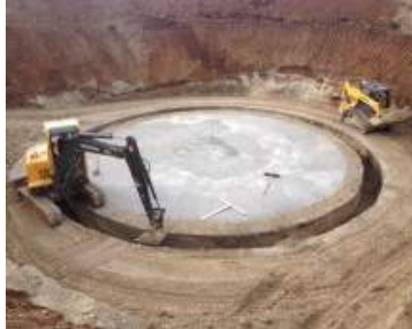
Excavación de zanja perimetral
