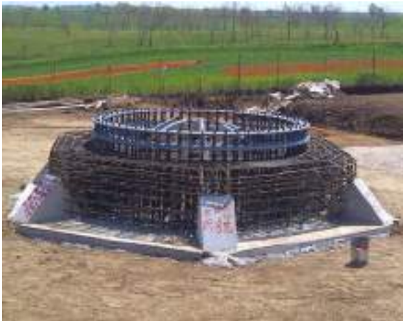
Resultado colocación armadura y jaula de pernos de la losa superior
