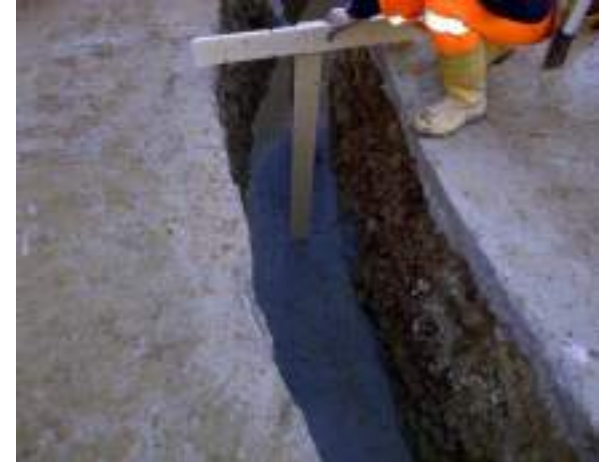
Hormigonado de limpieza en la zanja
