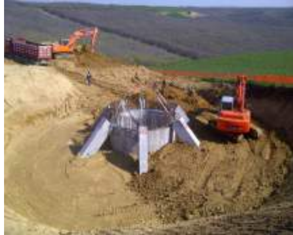
Relleno en el exterior del anillo (tongadas de 40cm)
