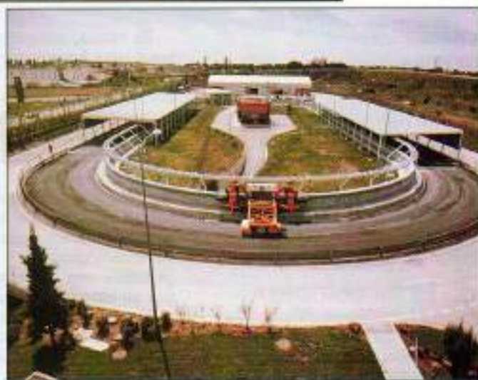
A la izquierda se encuentra la Torre de Comunicaciones de Montjuic (Barcelona), de Santiago Calatrava. Arriba, pista de ensayos a escala real para pruebas de firmes para carreteras.
