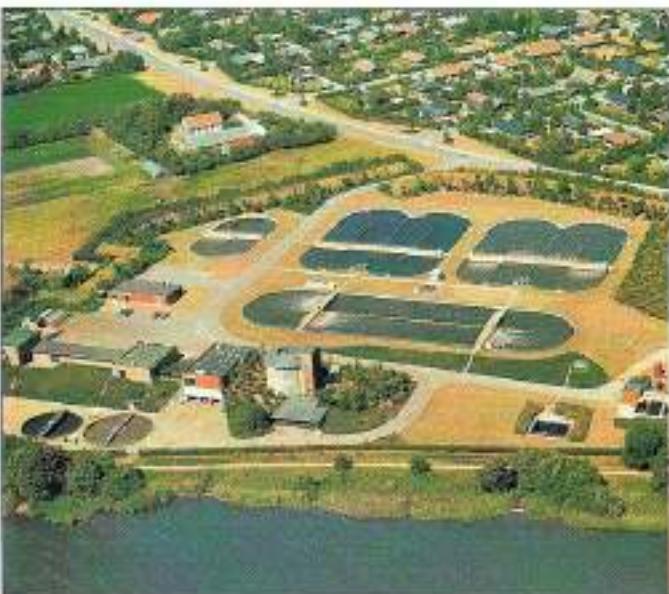
Las depuradoras de aguas residuales industriales, unas de las grandes beneficiadas por el Pitma.
