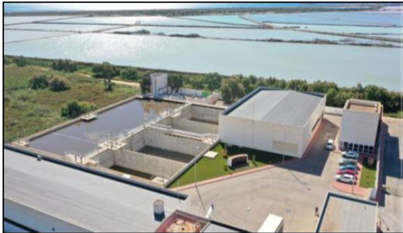
Foto EDAR junto al Mar Menor. San Pedro del Pinatar. ESAMUR
