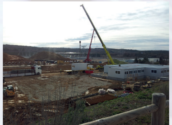
ITER project site
